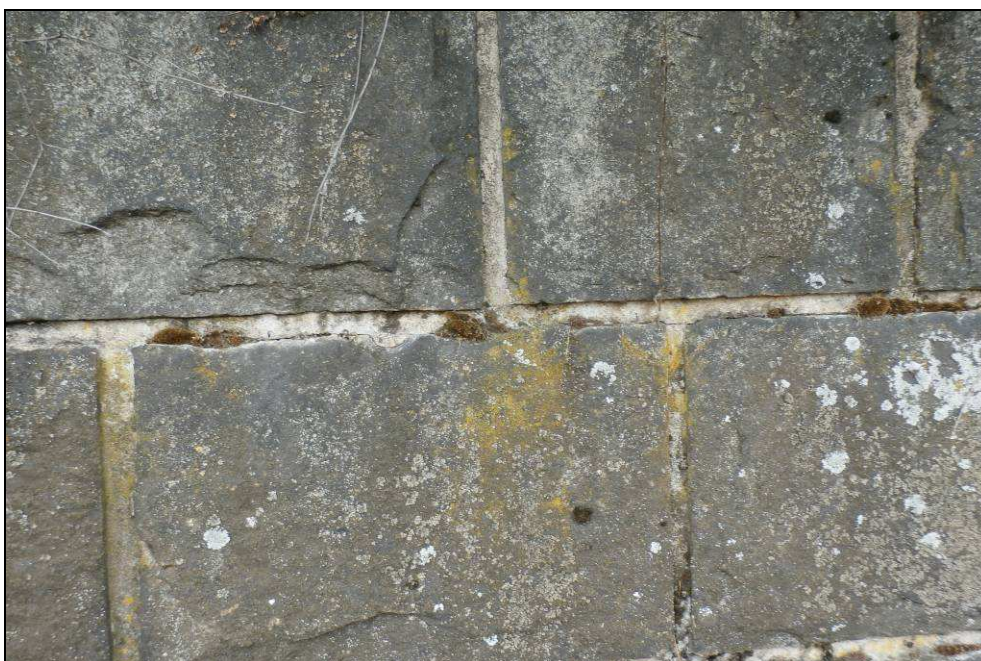
Obr. č. 8 - detail spárování zárubní zdi
